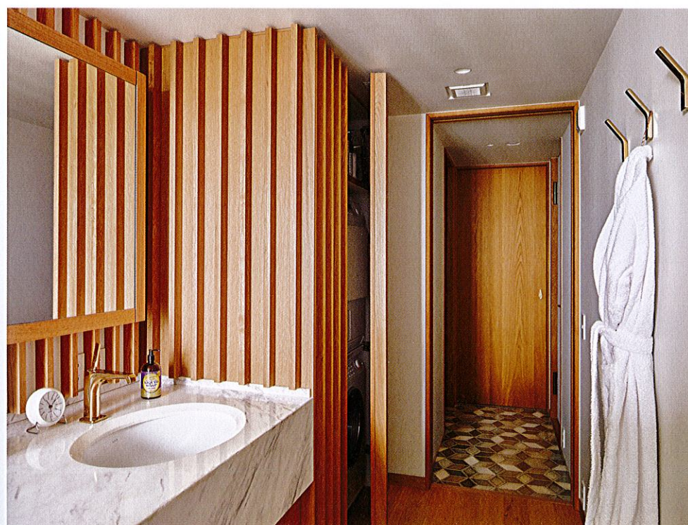
上/洗面室(CH2200mm)からバスルームを見る。洗 面器を二つ取り付けたカウンターの天板は大理石、ア ジャックスの本磨き。バスルームはユニットバスを採 用しながら、仕上げ材にモザイクタイルや御影石を用 いて素材感を添えている 下/洗面カウンター脇の収納には洗濯機と乾燥機を 収め、オーク材のルーバーをあしらい空間に連続性を もたせた。ゴールドで統一したフックや水栓はドイ ツ・Hansgroheのもの
