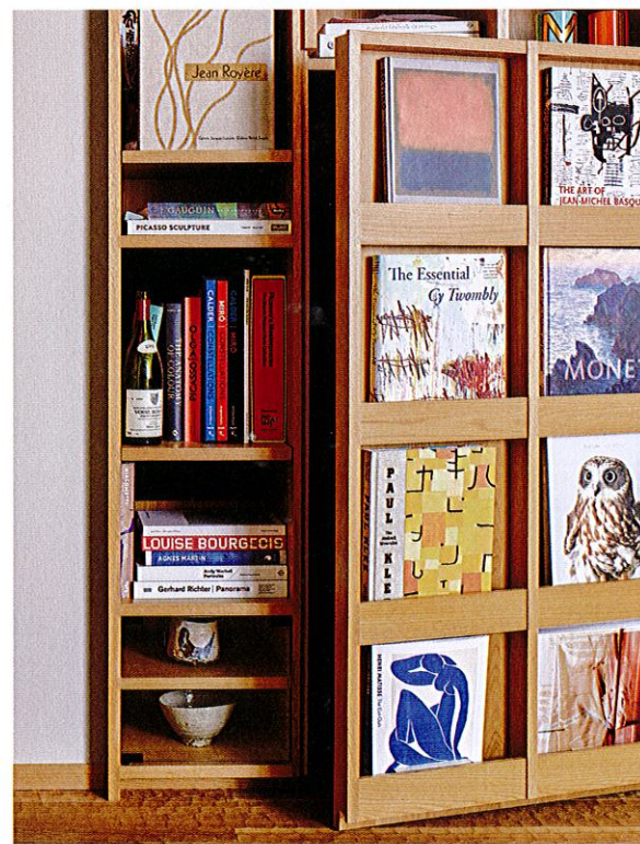
リビングの書棚にはフローリング材やほかの造作材と同じくオーク材を使用。 オーナーが愛するアート関係の書籍を多くディスプレイ。棚の一部は隠し扉で、 その奥には3.2㎡のライブラリーが設けられている
